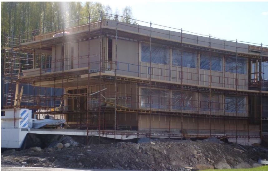
(Bilde fra byggearbeidet 06.05.09)
