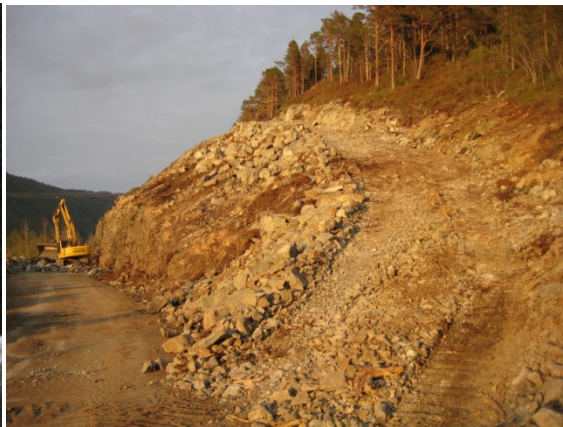
Anlagt pilotveg opp fjellsiden.
