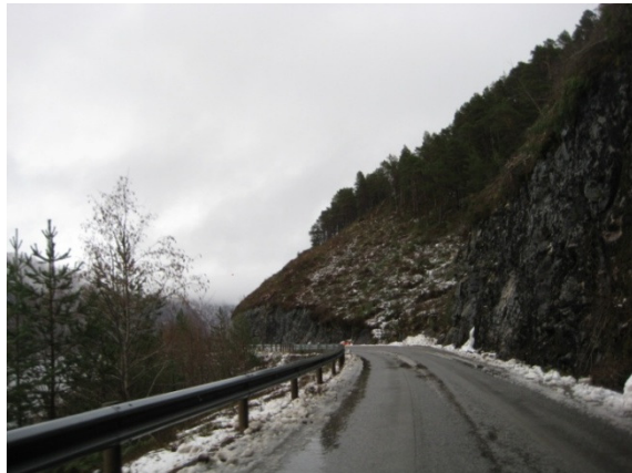
Ved profil. 5200, veldig bratt.
