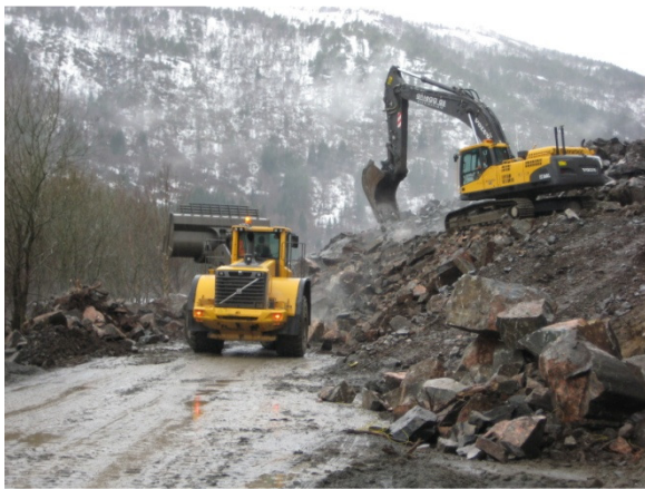
Her driver hjullasteren og åpner vegen (parsell 3).
