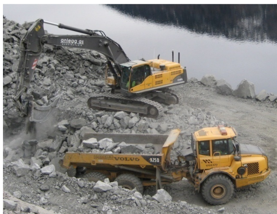
En gravemaskin laster opp sprengt stein på en dumper
