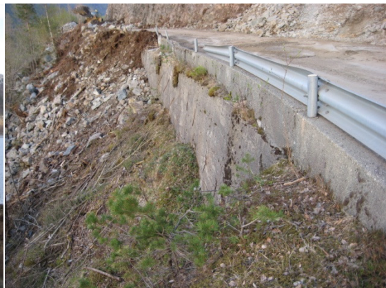
Plasstøpt betong som skal fjernes
