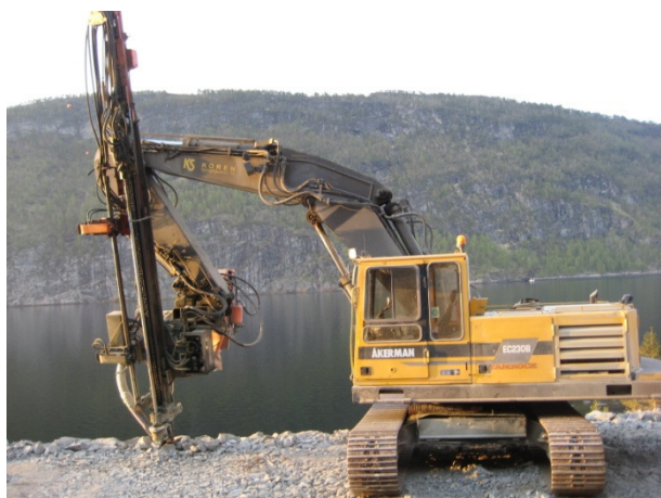
Gravemaskin med boreutstyr
